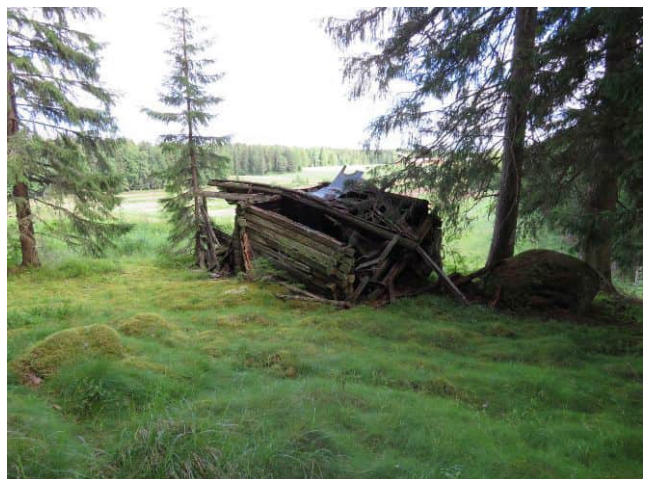
Romahtanut lato pellon reunassa, kuva pohjoiseen.
